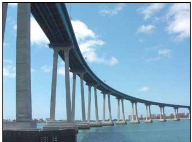
San Diego-Coronado Bridge
