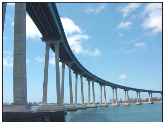
San Diego-Coronado Bridge
