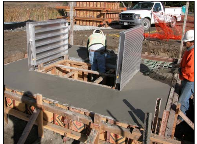
Pump Station 3A Top Slab Pour
