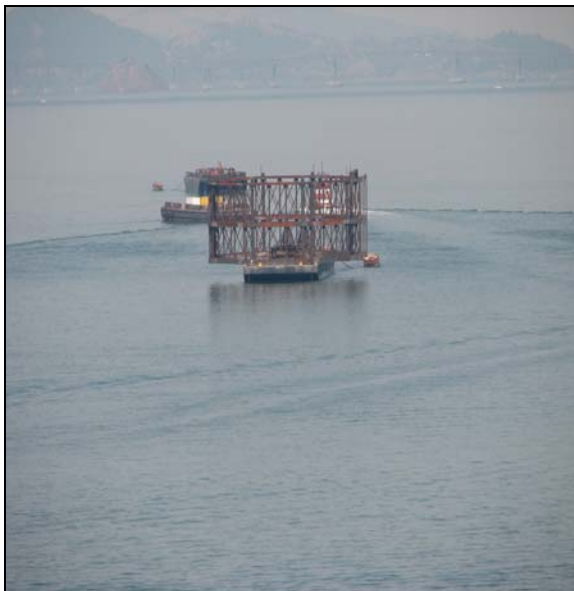
Cofferdam Frame for E2
