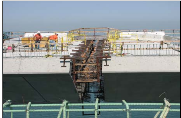
Closure Pour Span 5A
