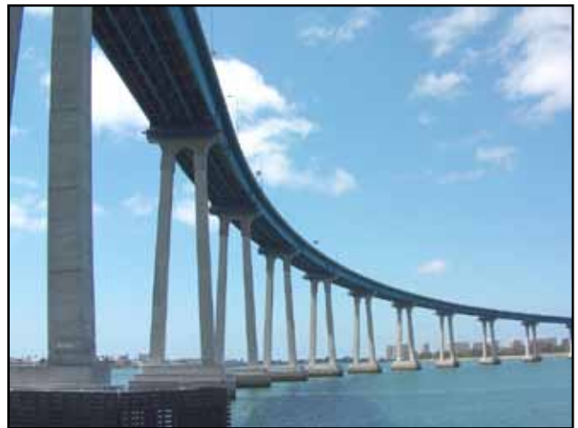
San Diego-Coronado Bridge
