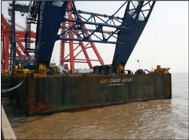
Shearleg Crane Barge
