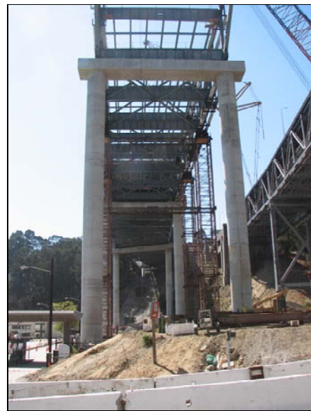
YBID - Viaduct Bent 51
