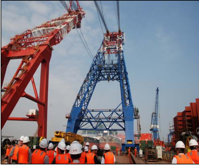
SAS – Shearleg Crane Barge Boom
