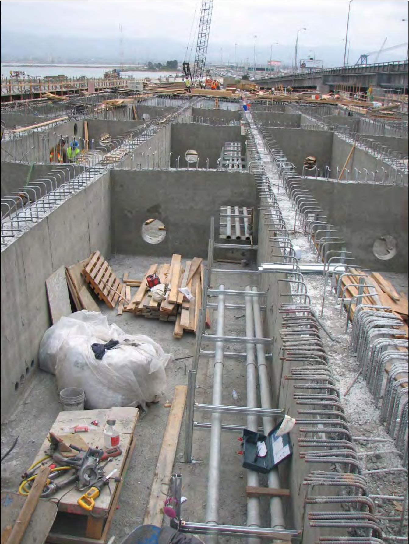
OTD Span18 Conduit Installation
