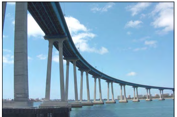
San Diego-Coronado Bridge
