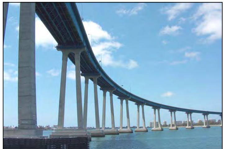
San Diego-Coronado Bridge
