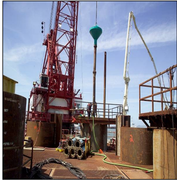
E2/T1- concrete pour for the T1 temp pile casing support 1
