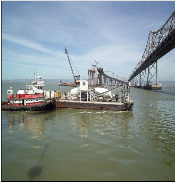
E2/T1 concrete pour for the T1 temp pile casing support 5
